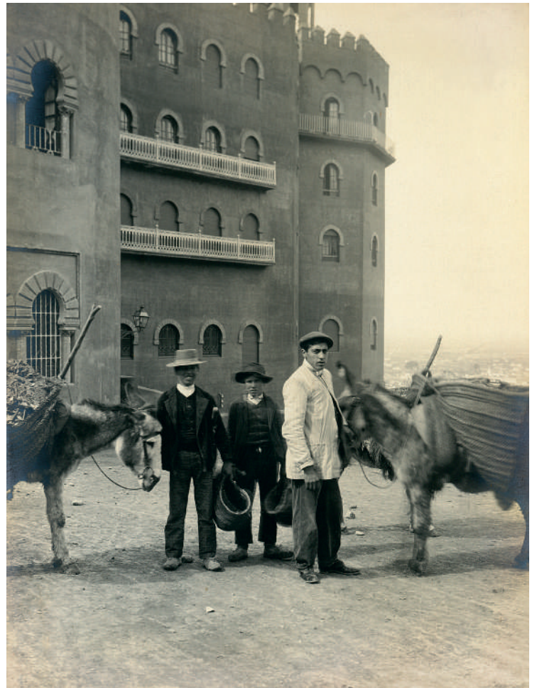
Arrieros llevándose con burros los escombros de la construcción Muleteers carrying construction debris with donkeys
