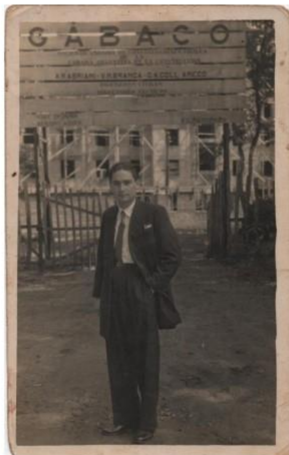
Valentín Zenón Capli, empleado de la empresa G.A.B.A.C.O. frente a la obra. 1960
