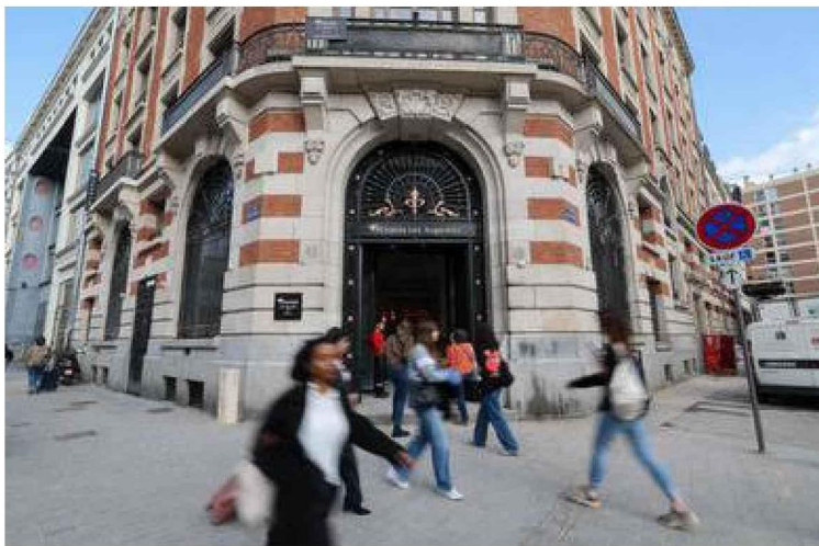
Inauguré dans les années 1930 à l'angle des rues du Molinel et des Augustins, le splendide siège social de la banque Scalbert-Dupont devient hôtel quatre étoiles. Photo F. M.
